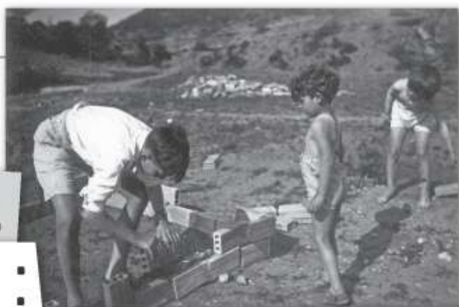
Les grands au travail : construction de maison. 1933 Arch. AAF
