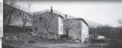
Installation à la pension de Beauvallon Septembre 1929 Arch. AAF
